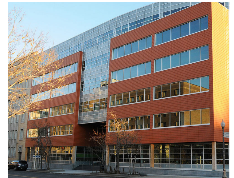
Utilisation de bois d'ingénierie apparent au rez-de-chaussée de l'Édifice Fondation à Québec.
