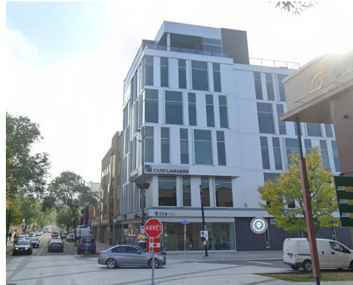
Utilisation de l'aluminium dans les revêtements extérieurs au 190 rue Racine Est, à Saguenay.
