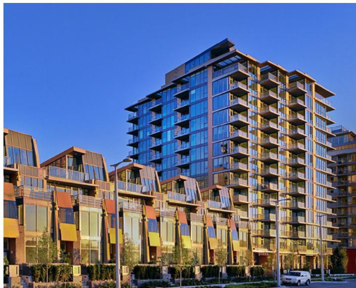
Cohabitation de différents types d'habitation et de différentes hauteurs de bâtiment dans le village Olympique de Vancouver.
