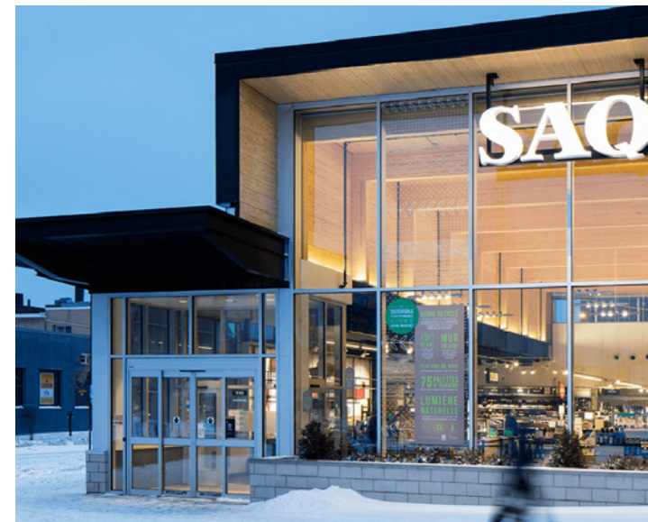
Utilisation de bois dans le bâtiment de la SAQ du Marché Jean-Talon à Montréal.
