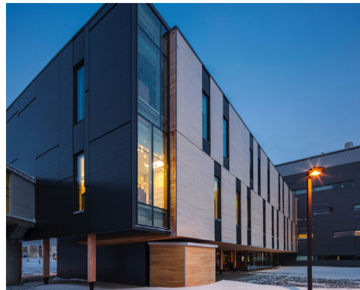
Utilisation de bois dans la structure et les revêtements du Pavillon des sciences de l'UQAT à Rouyn-Noranda.
