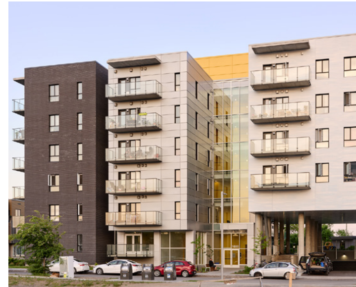
Mélange de briques et d'aluminium dans les revêtements extérieurs dans le projet Un Toit Vert de l'écoquartier d'Estimauville à Québec.
