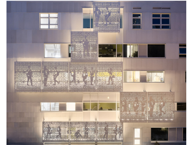
Utilisation de l'aluminium dans les revêtements extérieurs et les détails architecturaux de la nouvelle Maison L'Auberivière à Québec.
